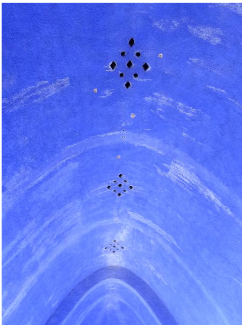
Détail de la voûte.
