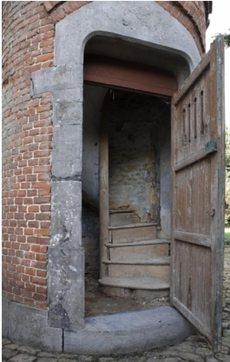
Détail de la porte de la tourelle et du départ de l'escalier.
