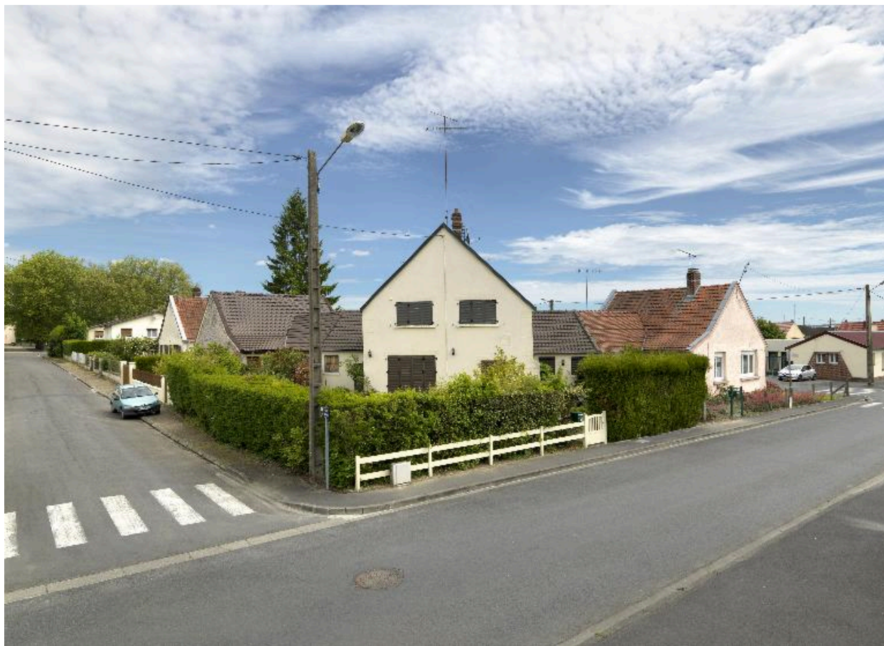
Maison à trois unités d'habitation, type à living-room (1-3, rue de Reims).
