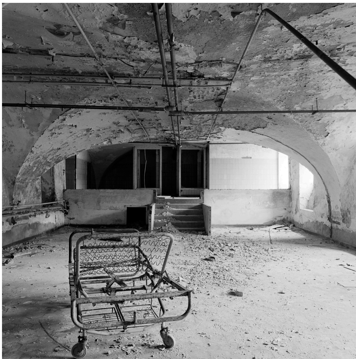
Bâtiment D, sous-sol, voûtement, vue vers l'escalier.
