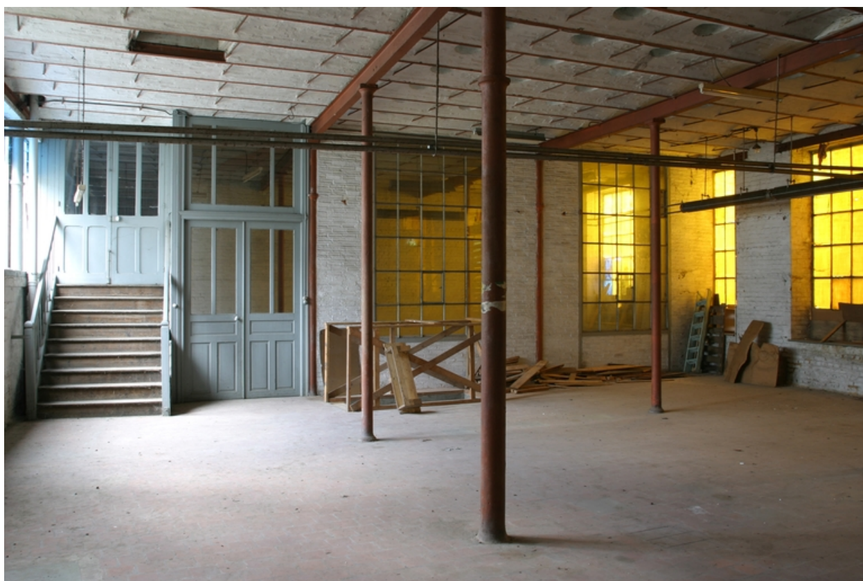
Rez-de-chaussée de l'atelier de 1900.
