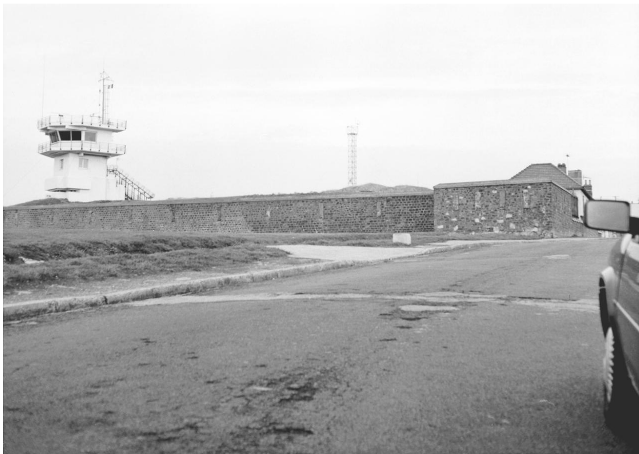
Façade partielle ouest.
