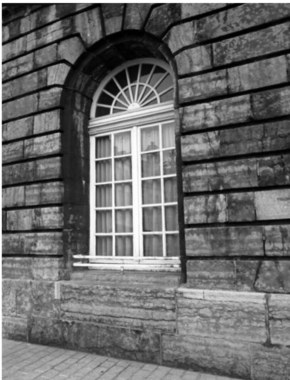
Façade, avant-corps central, premier niveau, baie de gauche.
