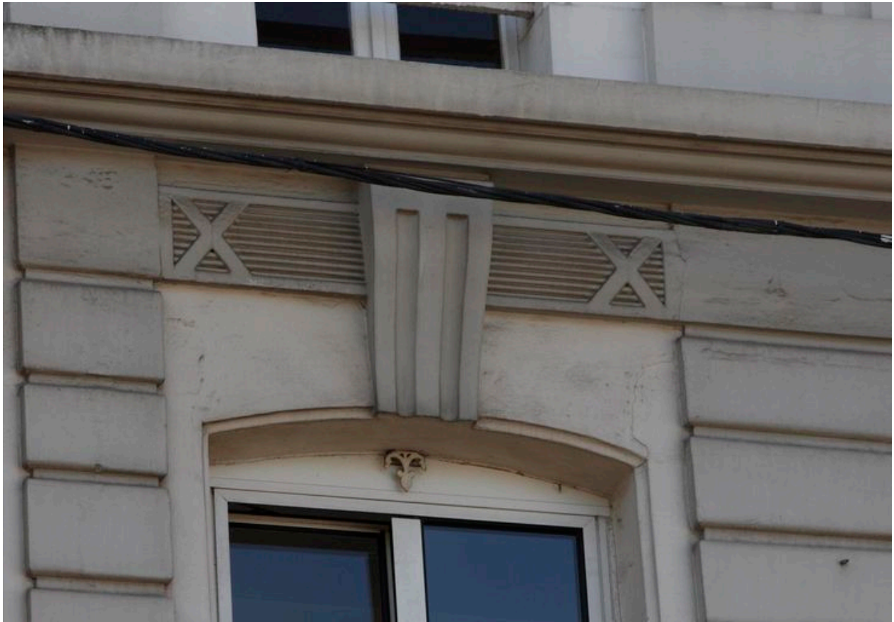
Motifs géométriques des linteaux.
