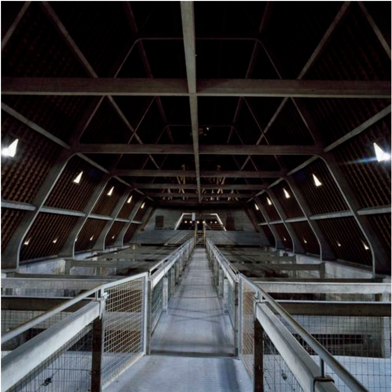
Charpente en béton du vaisseau central, d'ouest en est.
