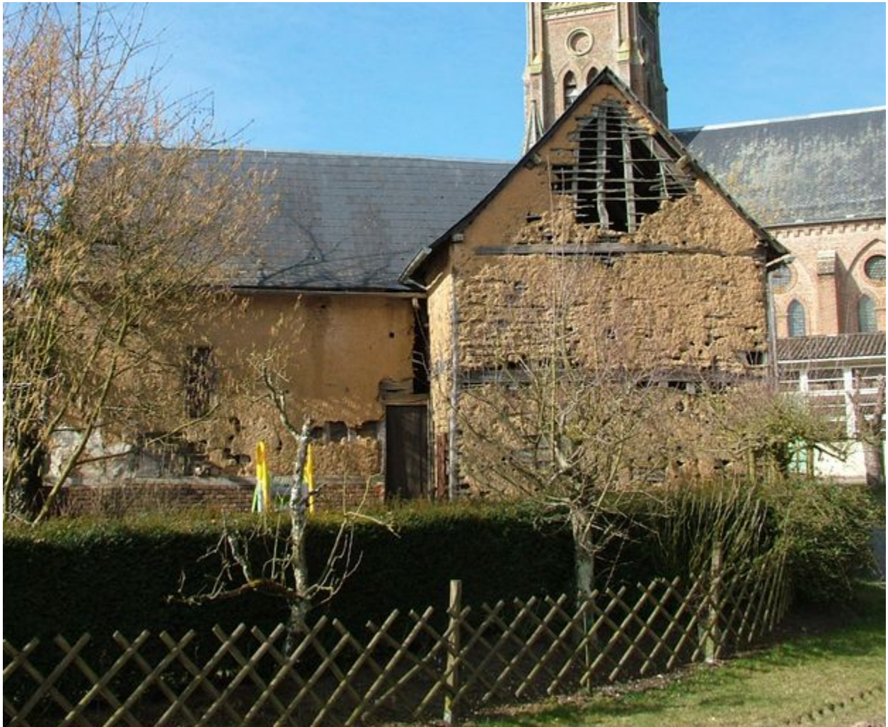
Bâtiments en torchis à l'arrière de l'ancien café, 2 place de l'Eglise, 19e siècle.
