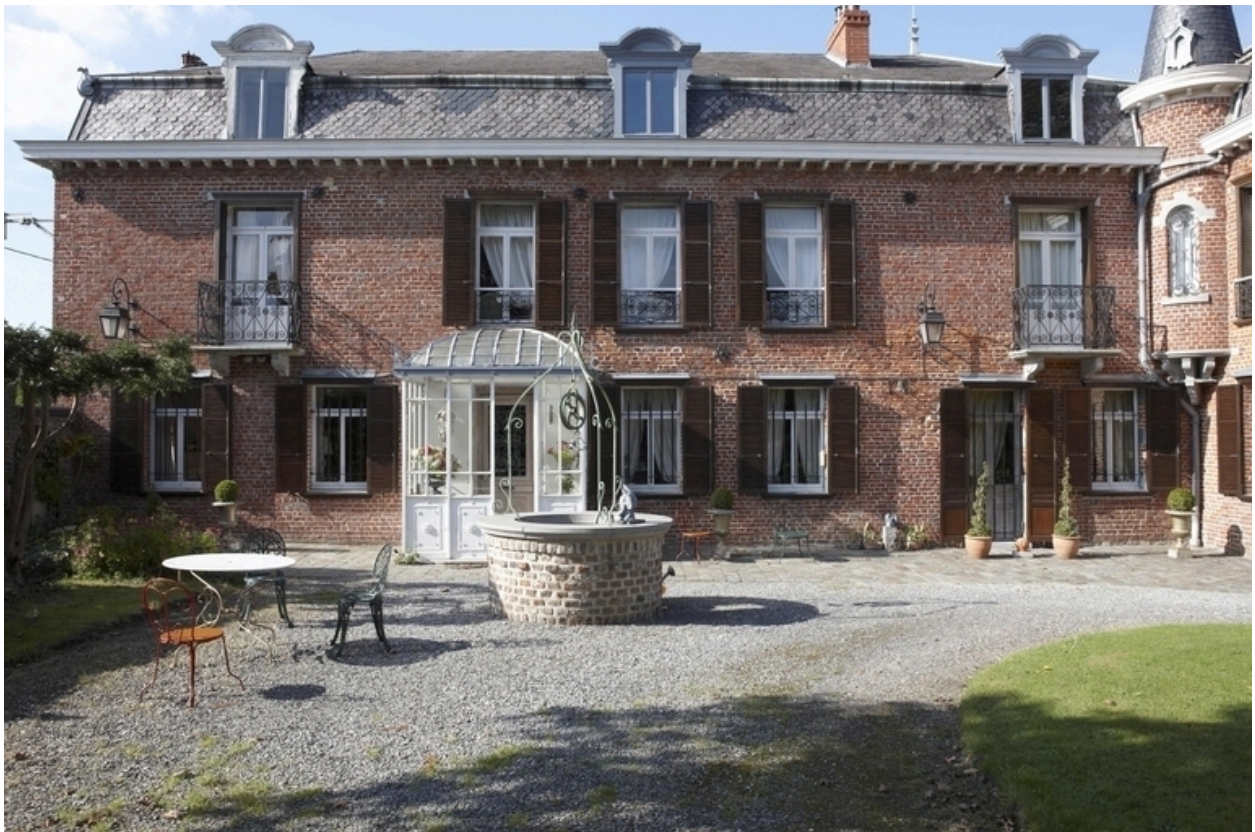
Vue du bâtiment surélevé.
