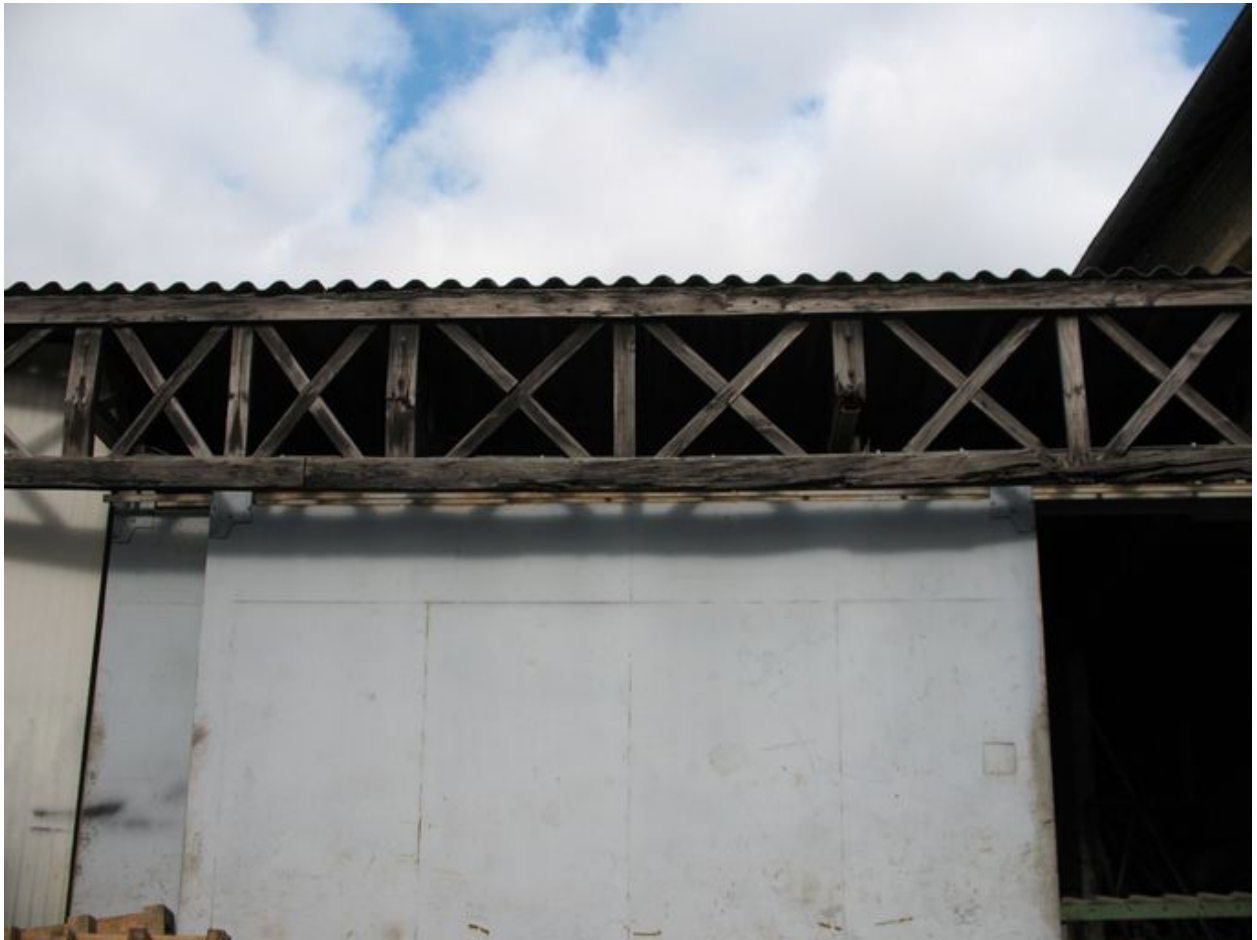
Détail de la charpente en bois entre l'atelier et le magasin.
