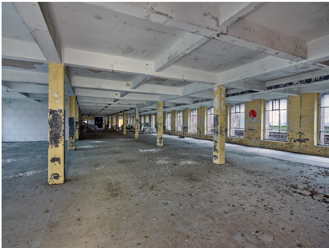
Vue intérieure du deuxième étage de l'atelier de fabrication (bâtiment A).
