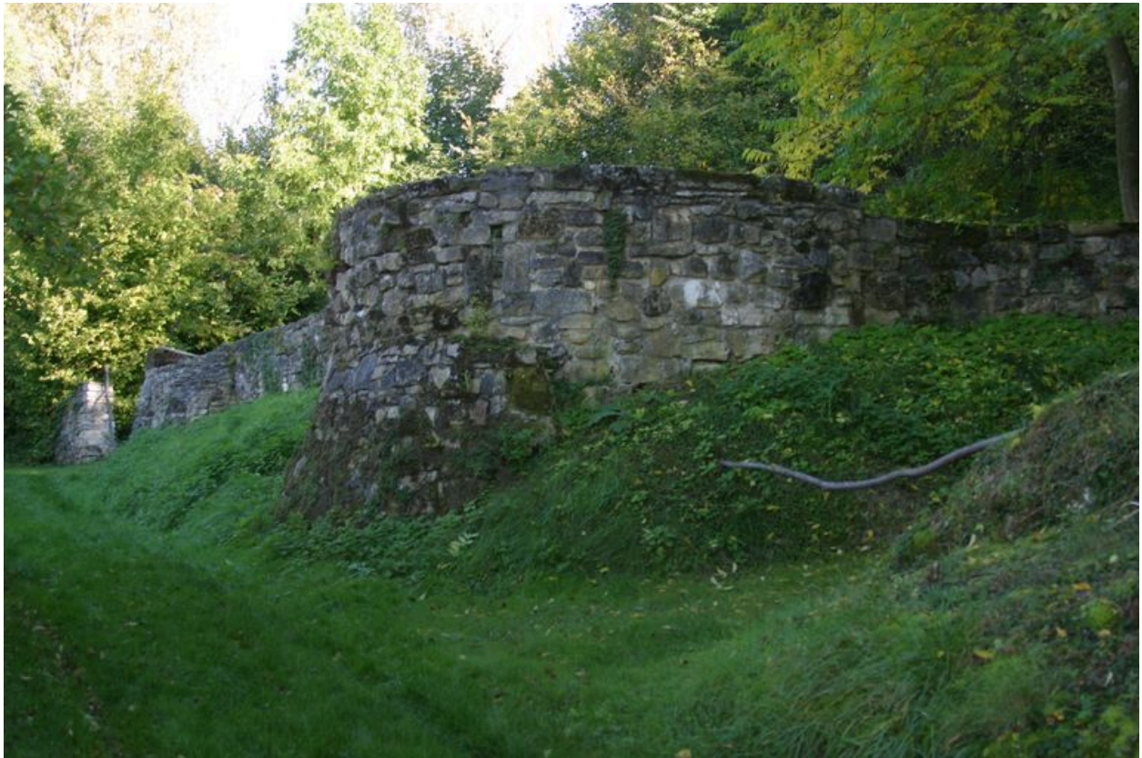
Vue du mur d'enceinte situé en fond de propriété.
