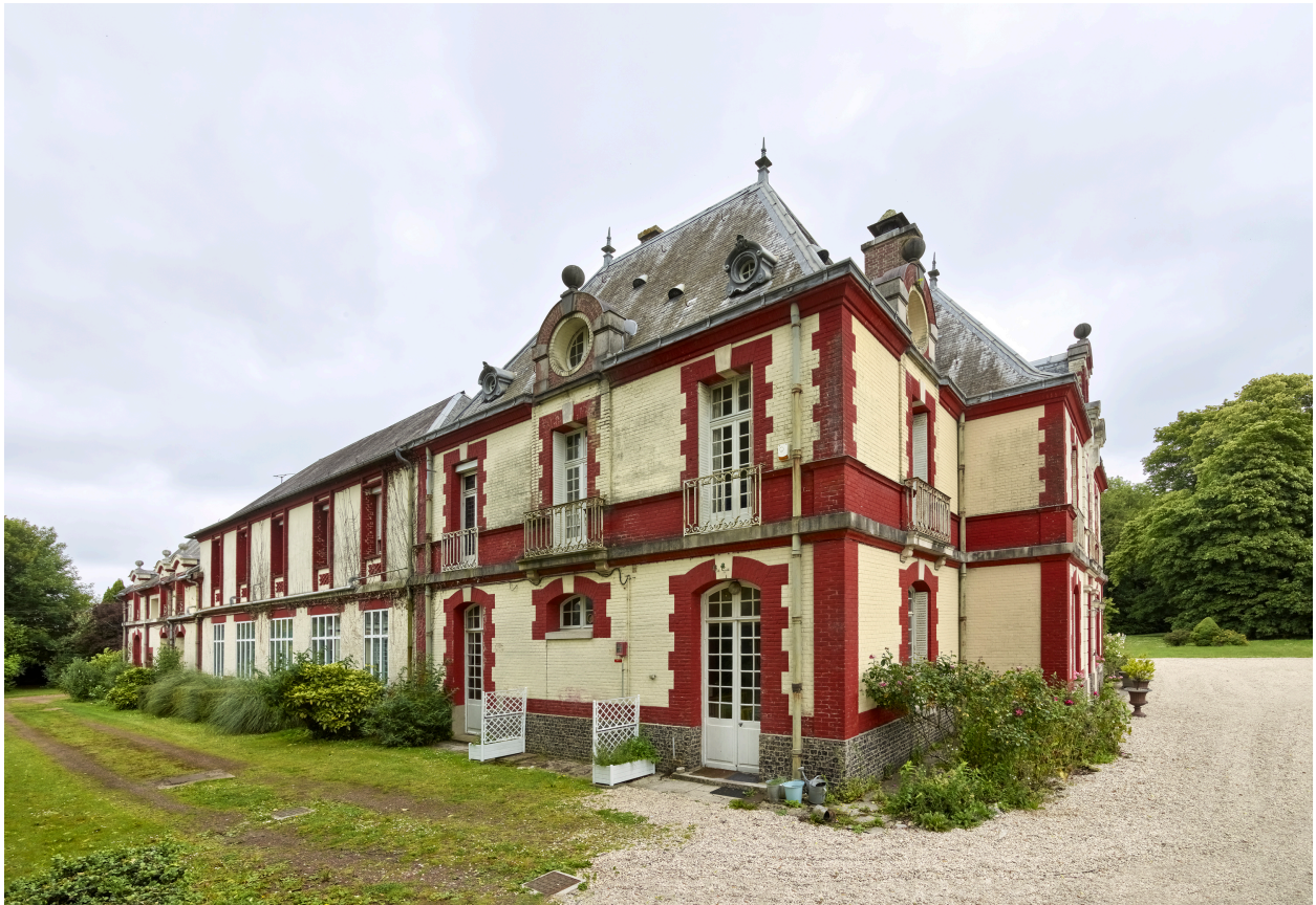
Vue de l'édifice, depuis l'ouest.
