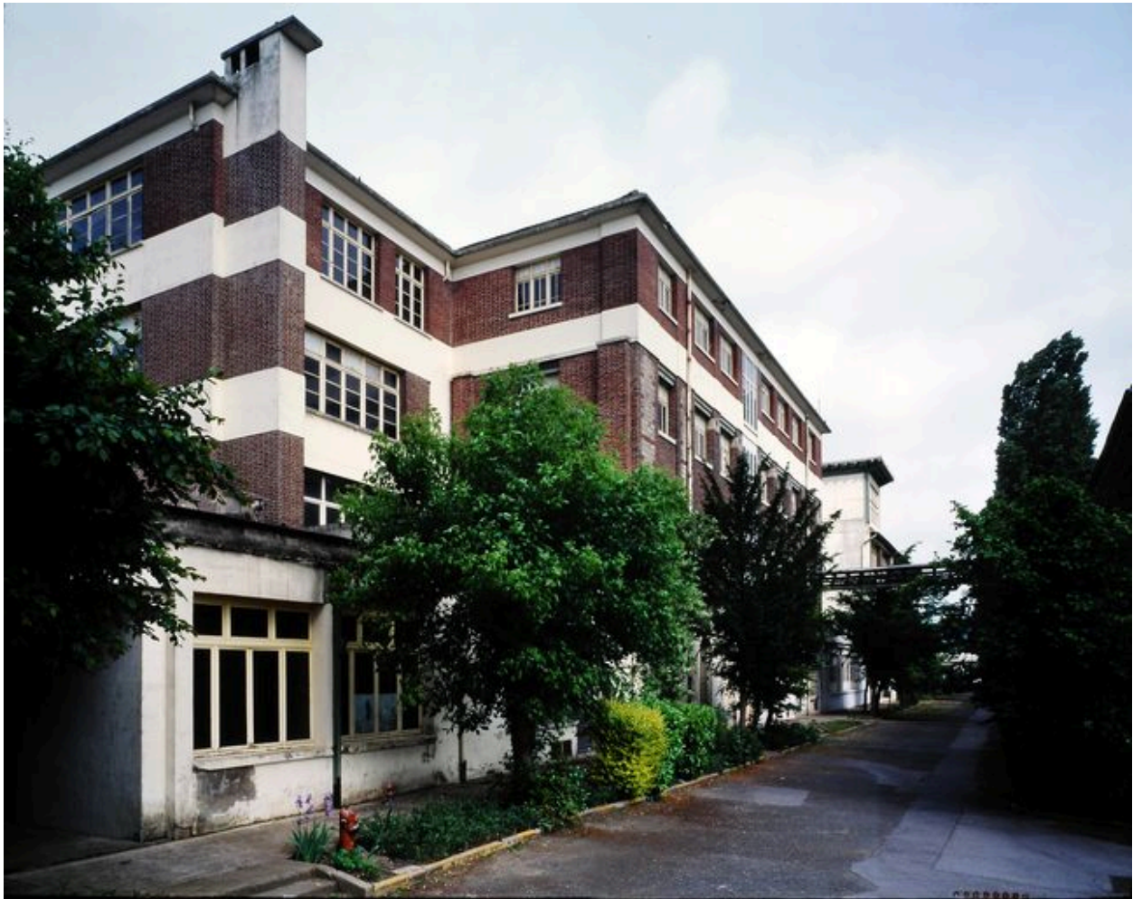
L'un des bâtiments de l'usine électrique (laboratoire et logements) agrandi pour le lycée Gournay.
