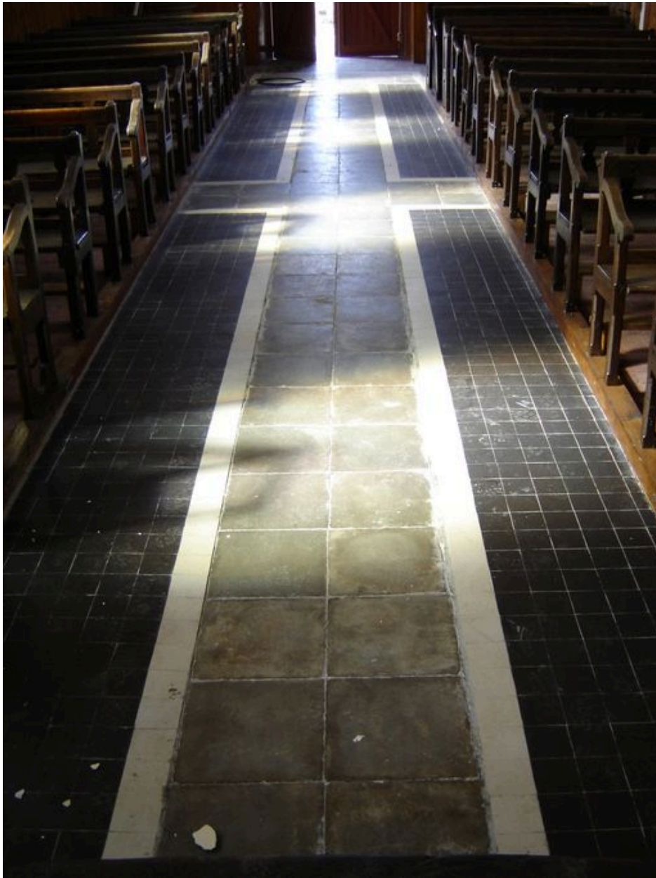
Vue du sol de la nef.
