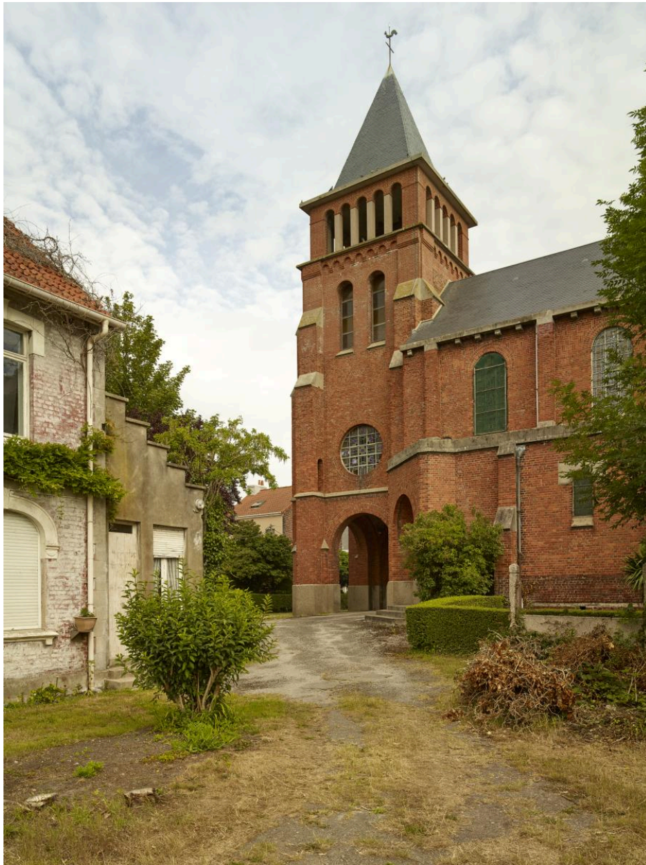
Le clocher-porche, vu depuis le sud-ouest, avec une partie du presbytère à gauche.
