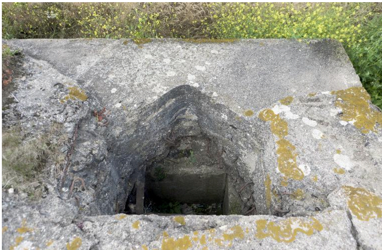
Logement de l'observatoire cuirassée, vers l'ouest
