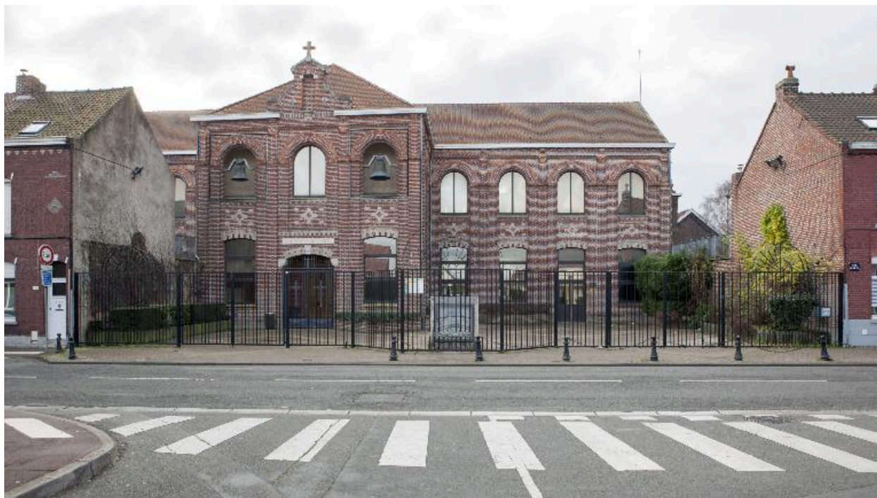
Élévation antérieure de la chapelle
