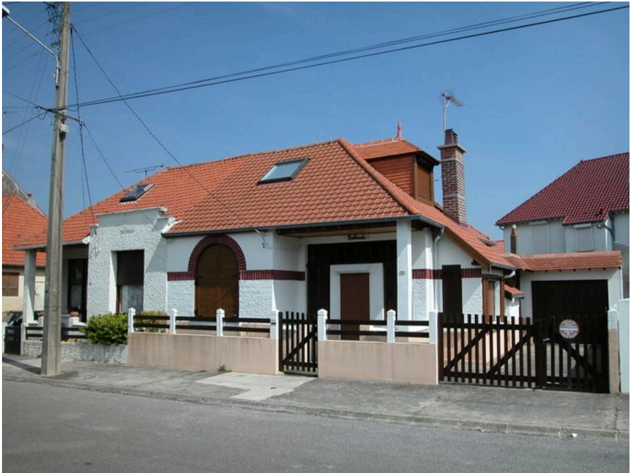
Vue d'ensemble, logement dit 'Pastorale' au premier plan.
