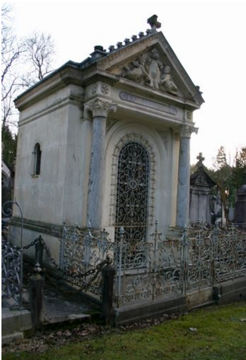
Vue générale, depuis le côté.
