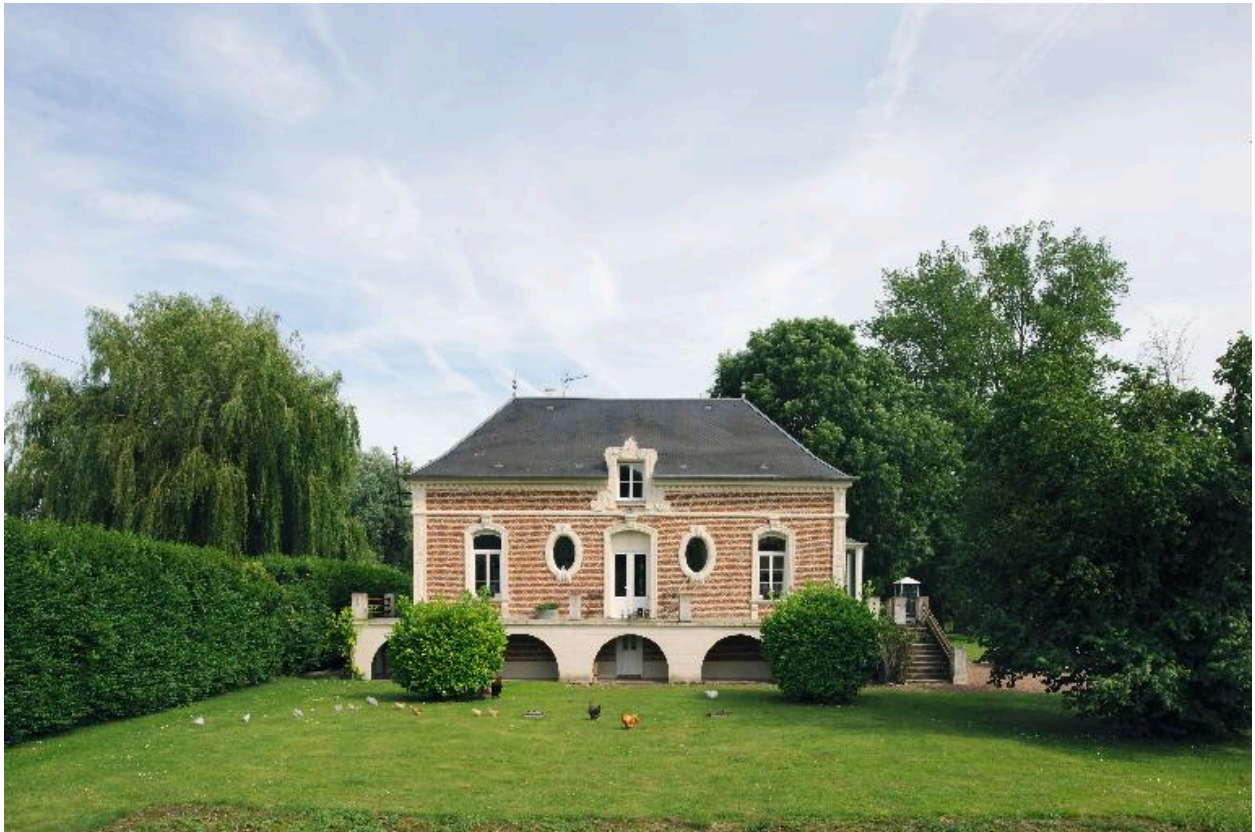
Vue d'ensemble de la façade principale.
