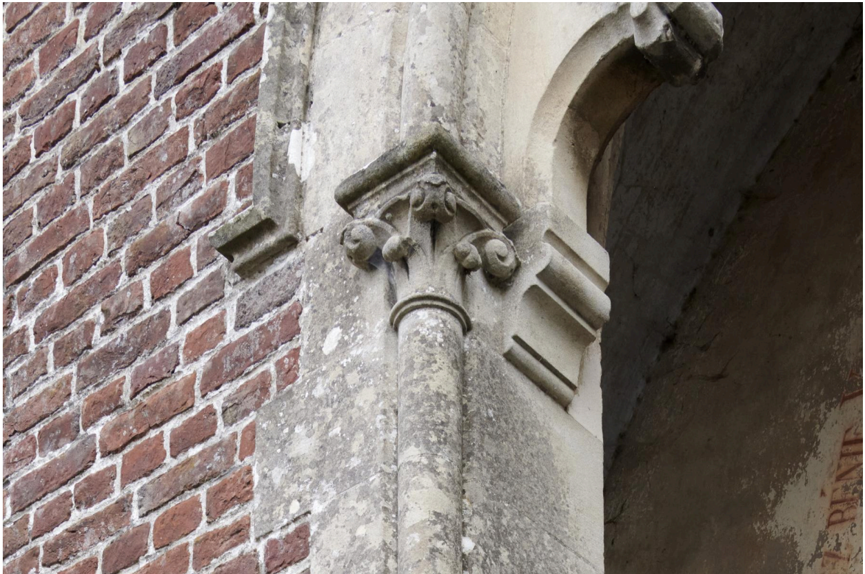
Détail architectural de l'entrée. Colonne avec motif végétal.
