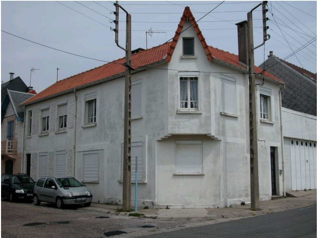
Vue d'ensemble depuis le carrefour rue des Dunes et de Paris, avec la maison dite Lou Contou au premier plan.
