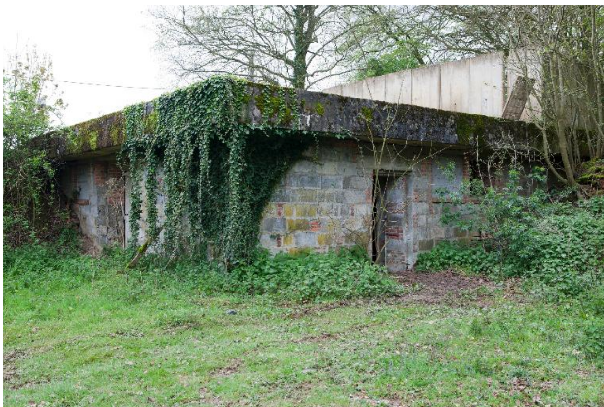
Vue générale du premier abri.
