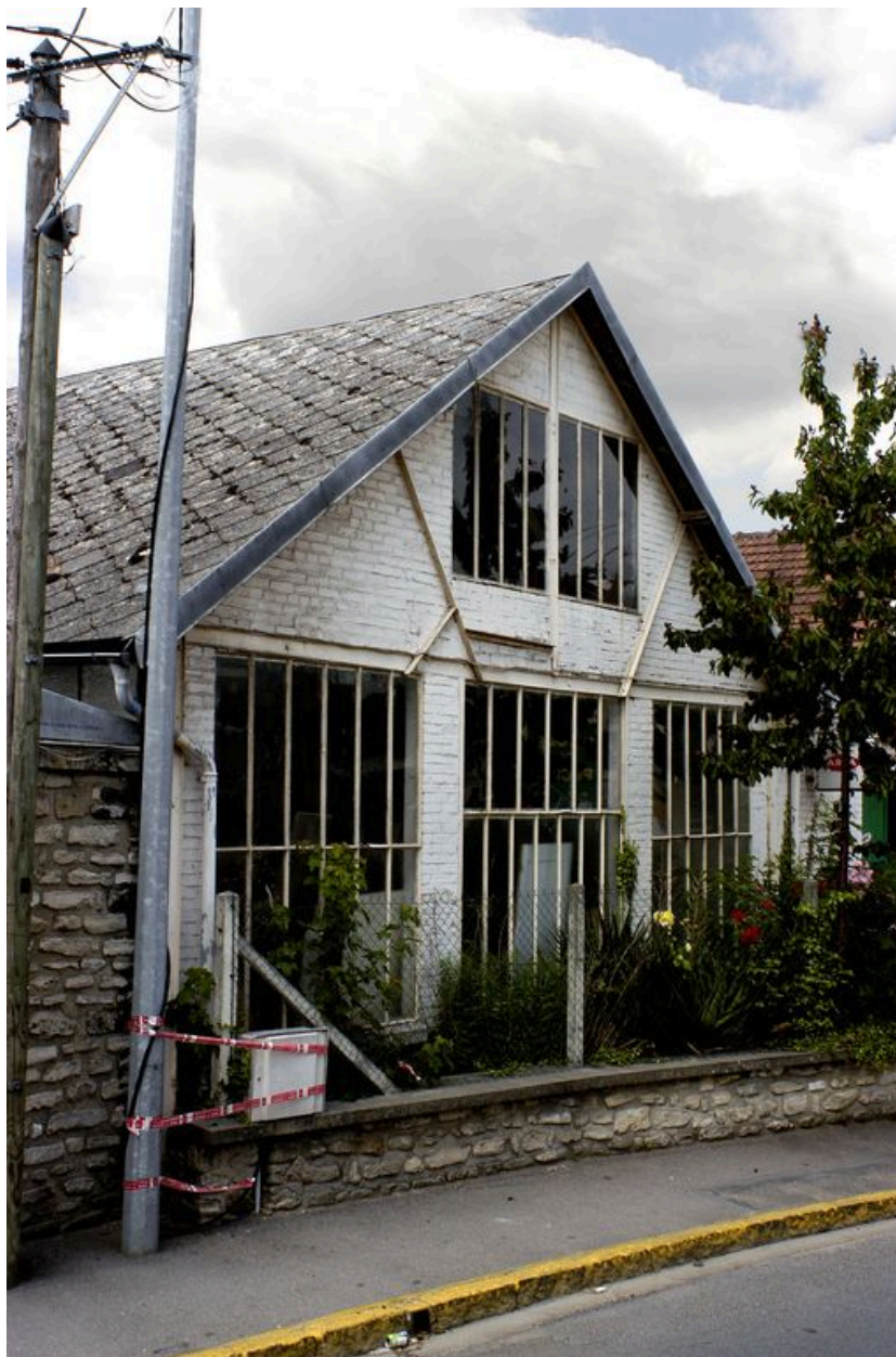
Pignon d'un des ateliers de fabrication.
