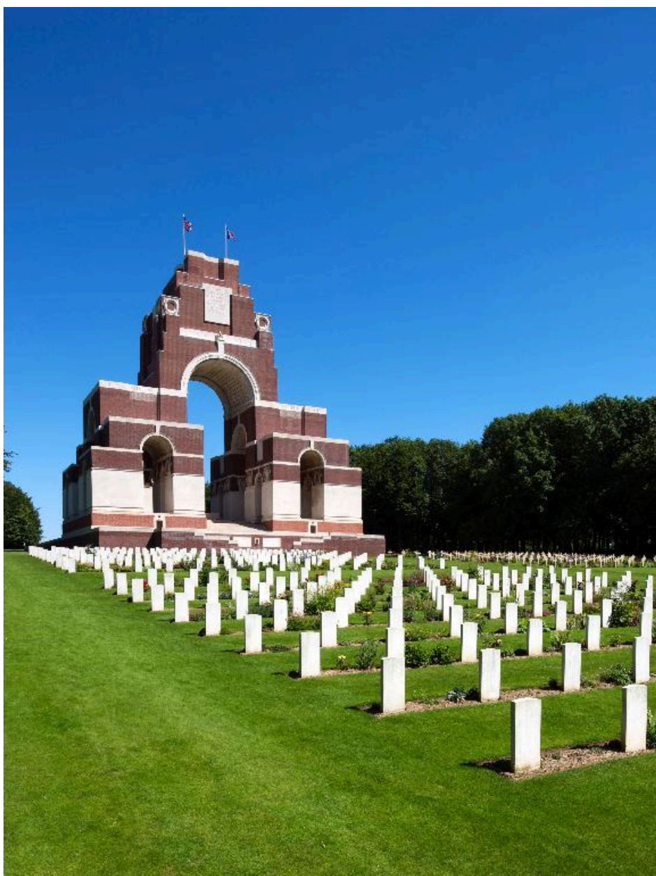
Vue du monument, depuis le nord-ouest.
