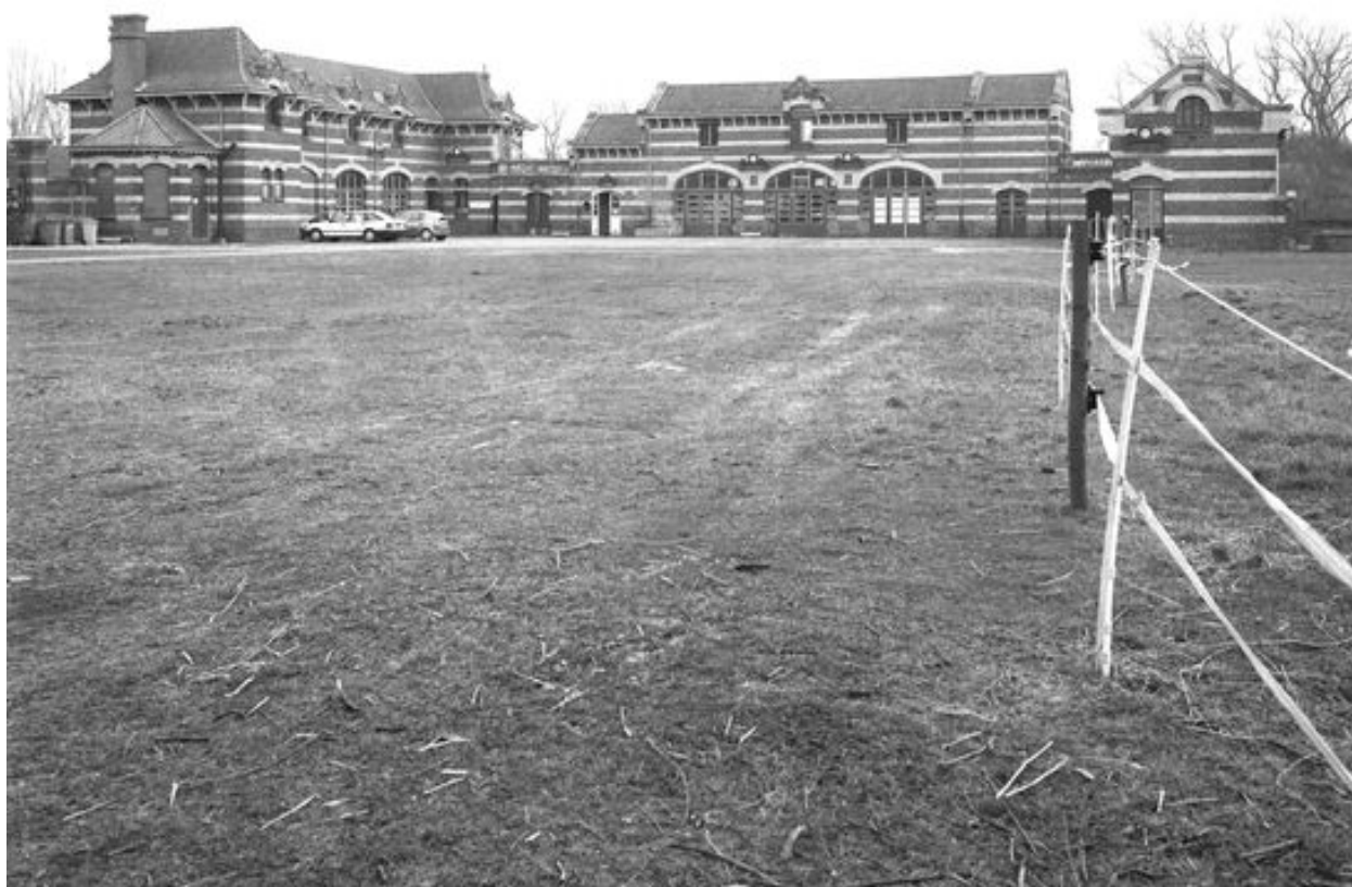
Façade sur cour des écuries, remises et du fenil fermant l'angle sud-est en 2003.
