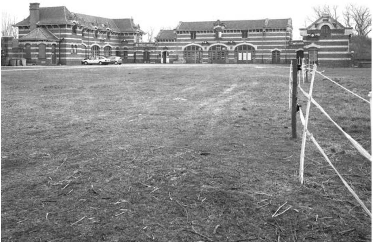
Façade sur cour des écuries, remises et du fenil fermant l'angle sud-est en 2003.
