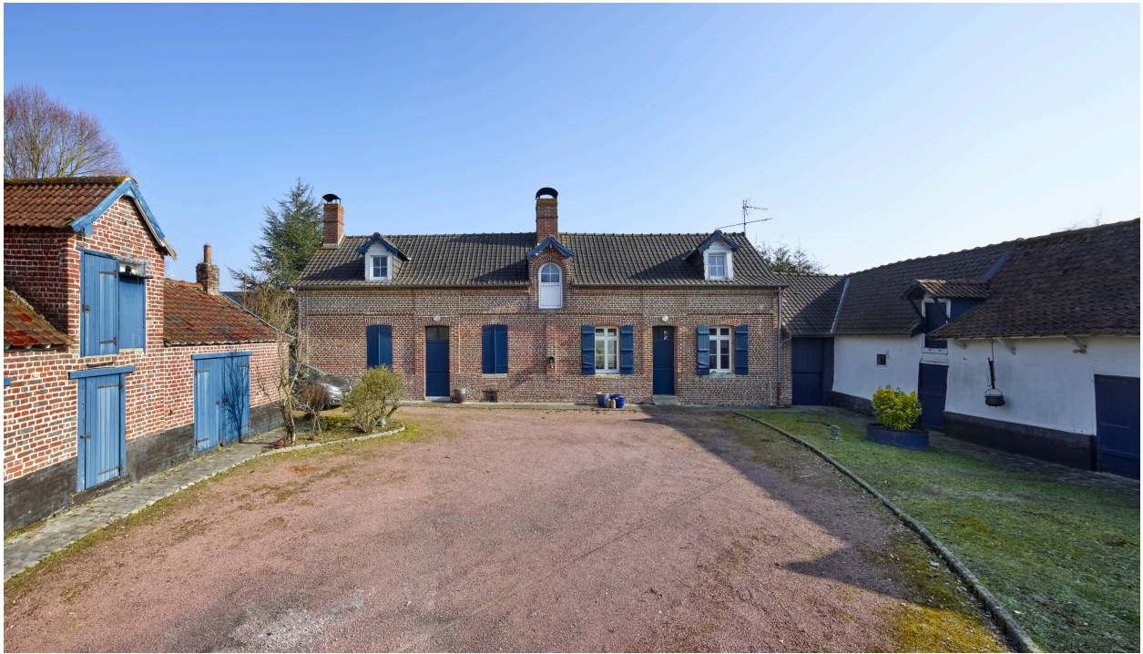
Ancienne ferme, 17 rue de Buigny.
