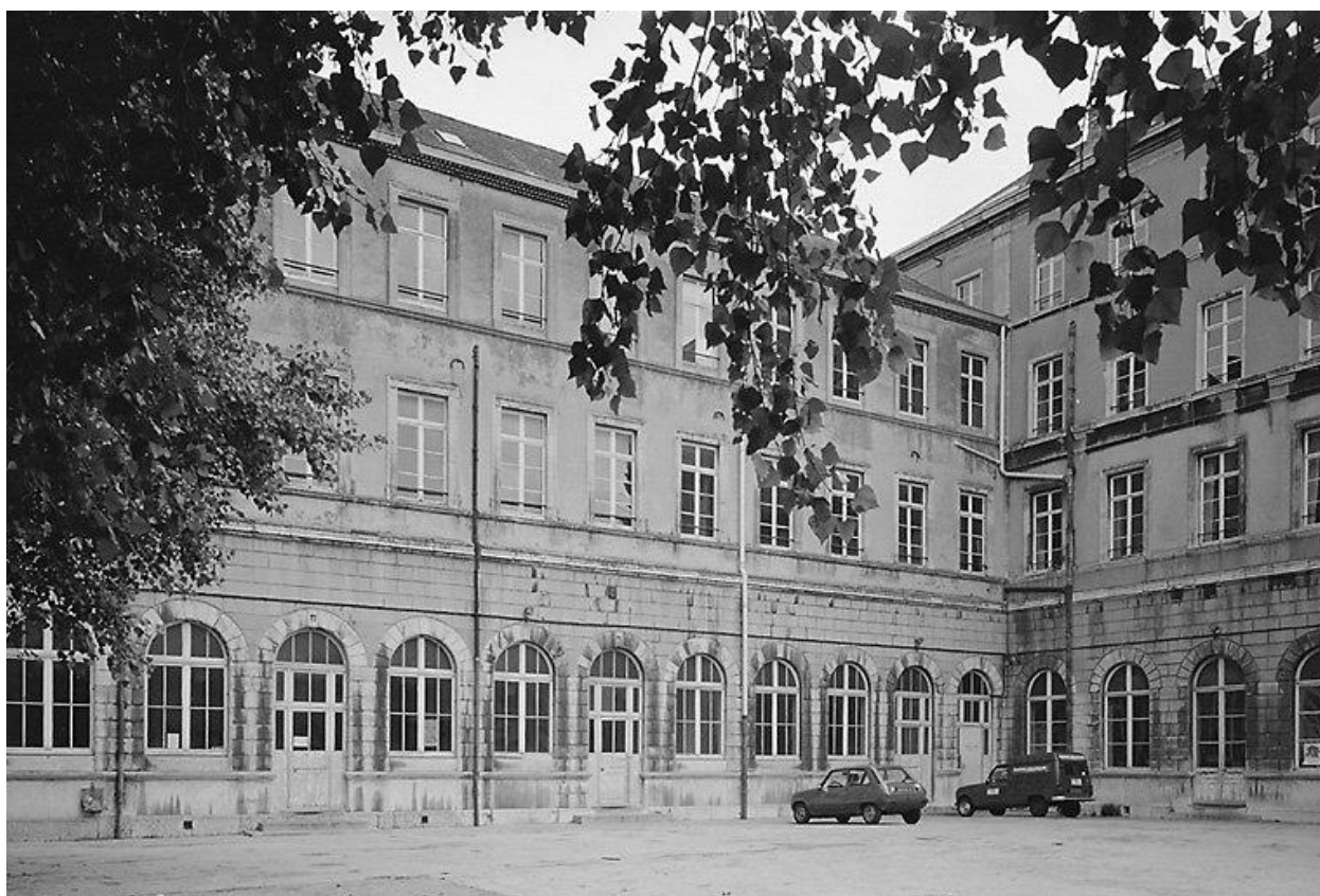
Rue des Pipots, bâtiments sur cour : vue d'angle.
