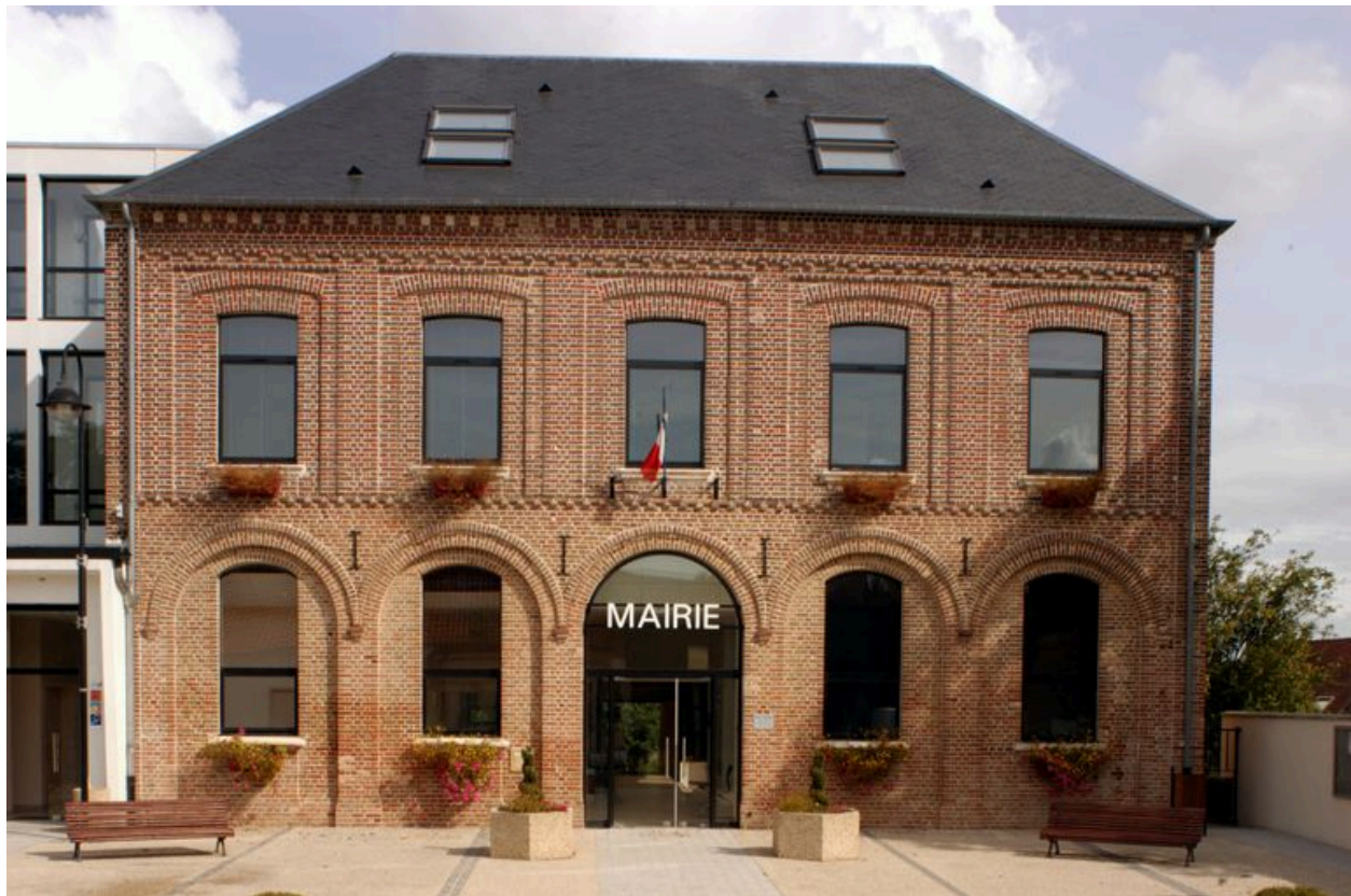
Vue de la façade sud.
