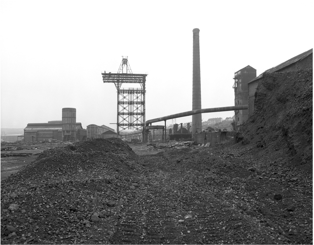
Vue d'ensemble (magasin général, réfrigérant, portique, cheminée d'usine, élévateur).
