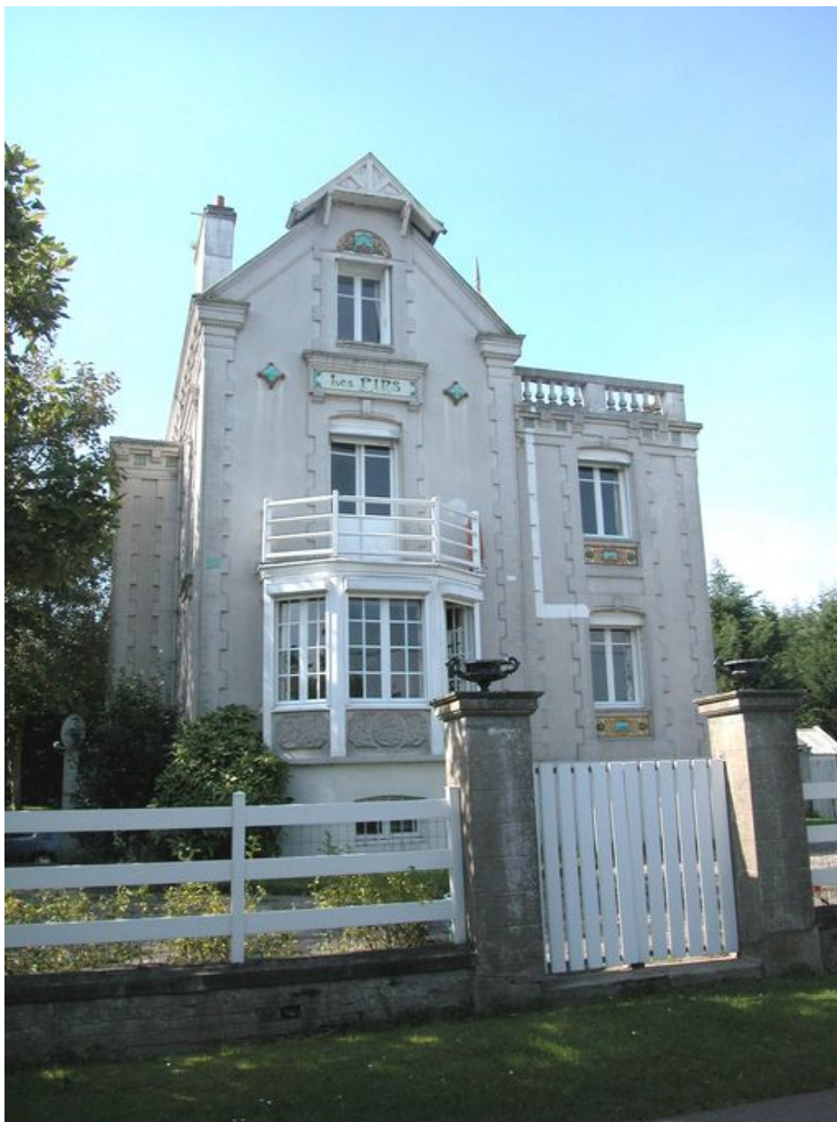
Vue d'ensemble de la façade antérieure.
