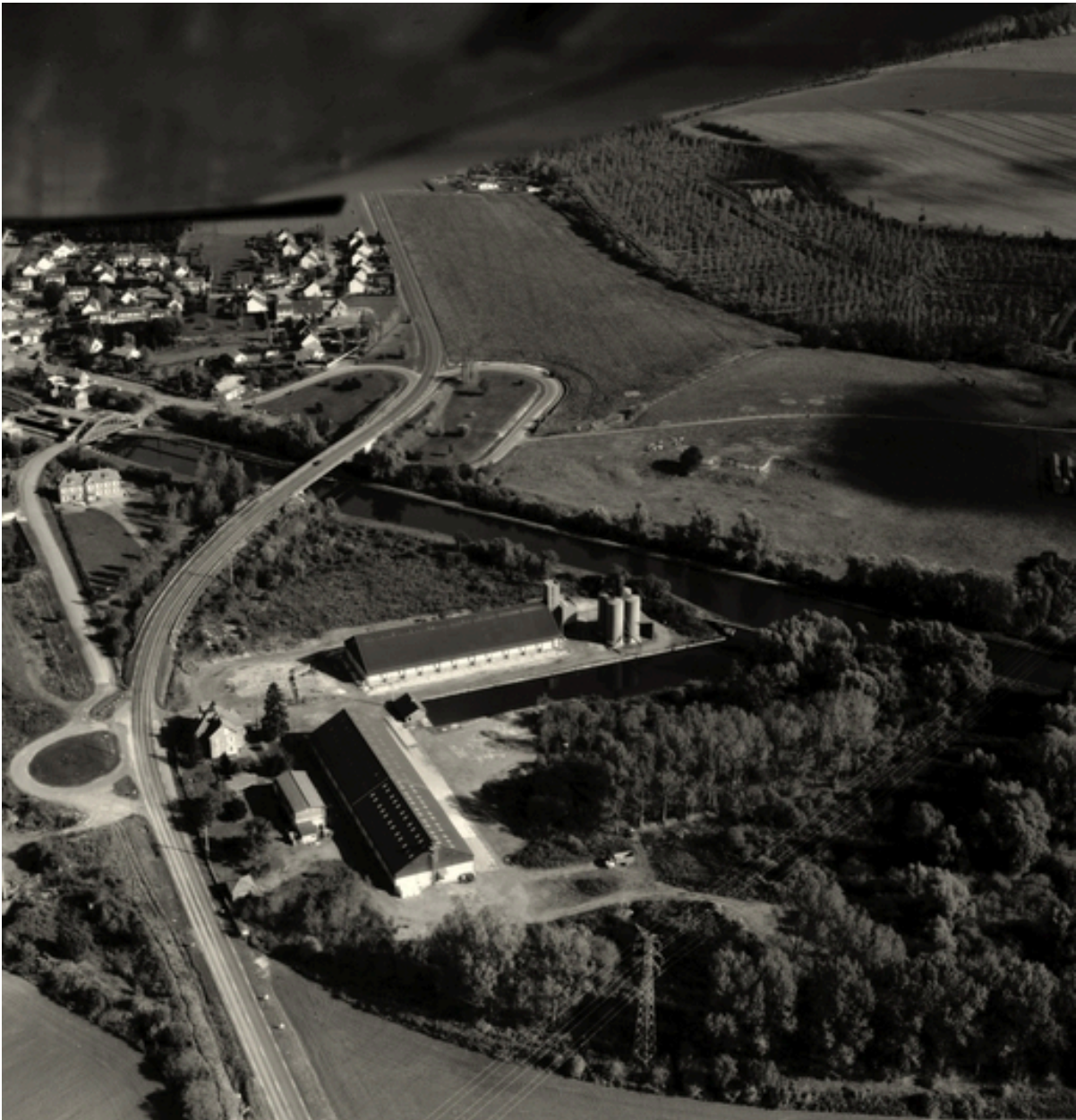
Omissy : vue aérienne de l'ancienne râperie de la Cie Nouvelle des Sucrieries Réunies.
