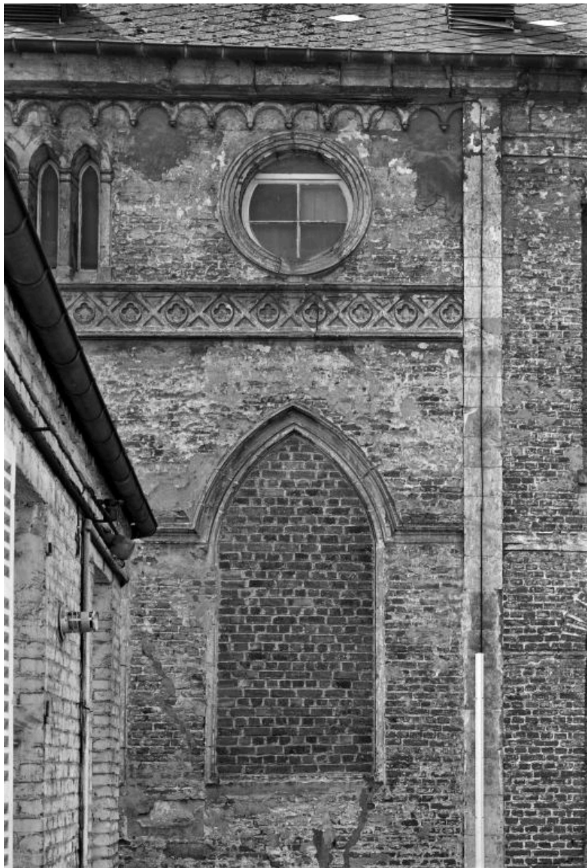
Détail d'une travée de la façade sur cour de la chapelle, devenue le cinéma "Vox".
