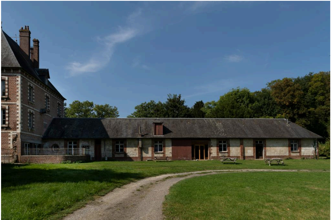
Vue du logis depuis l'est.
