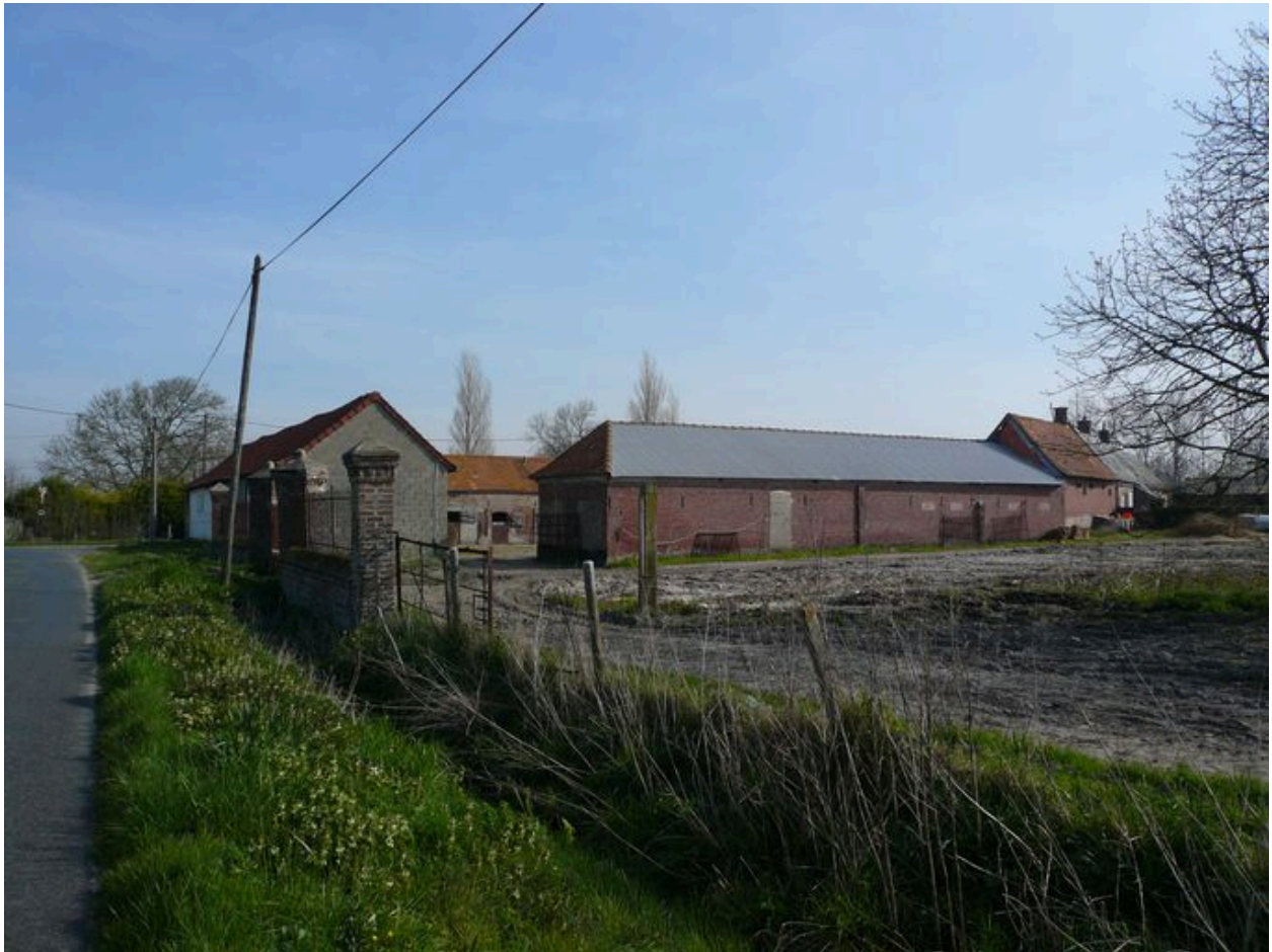
Vue générale de l'ensemble agricole depuis la sud-ouest.
