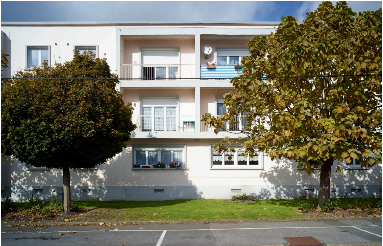
Vue du bloc A côté rue.
