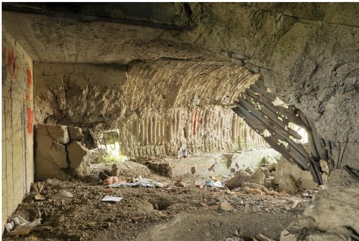
Edifice b. Vue intérieure depuis l'entrée
