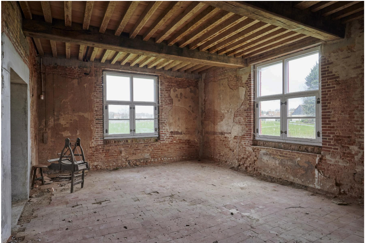
Rez-de-chaussée. Salle principale du logis du XVI e siècle.
