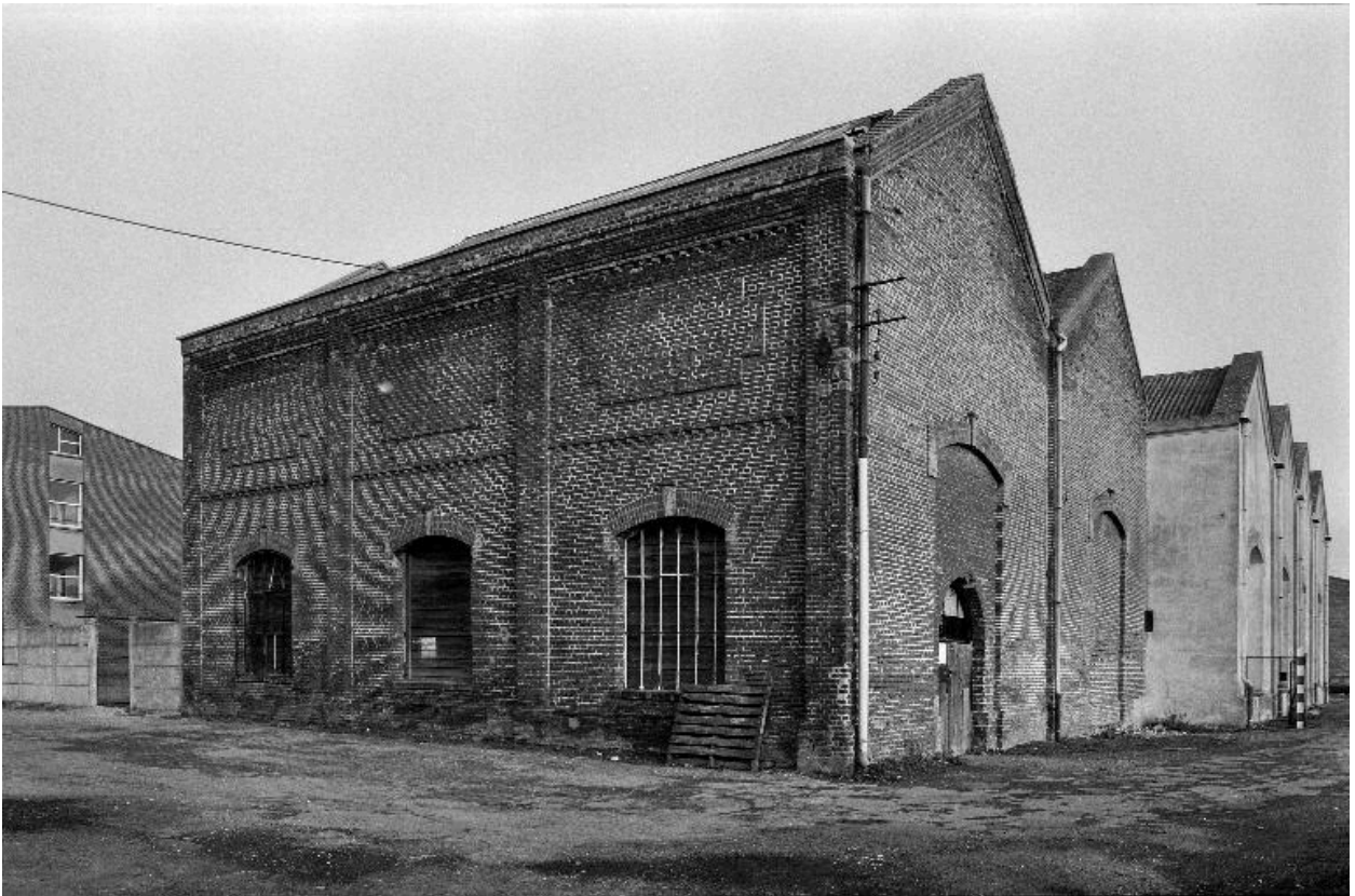
Chaufferie, flanc ouest.
