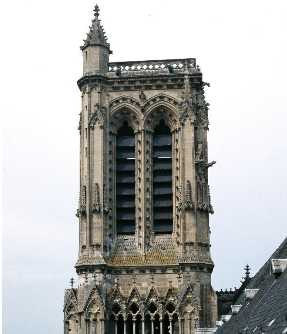
Vue du clocher de la tour sud-ouest.
