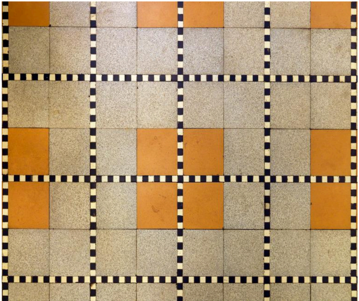
Détail du carrelage du préau.
