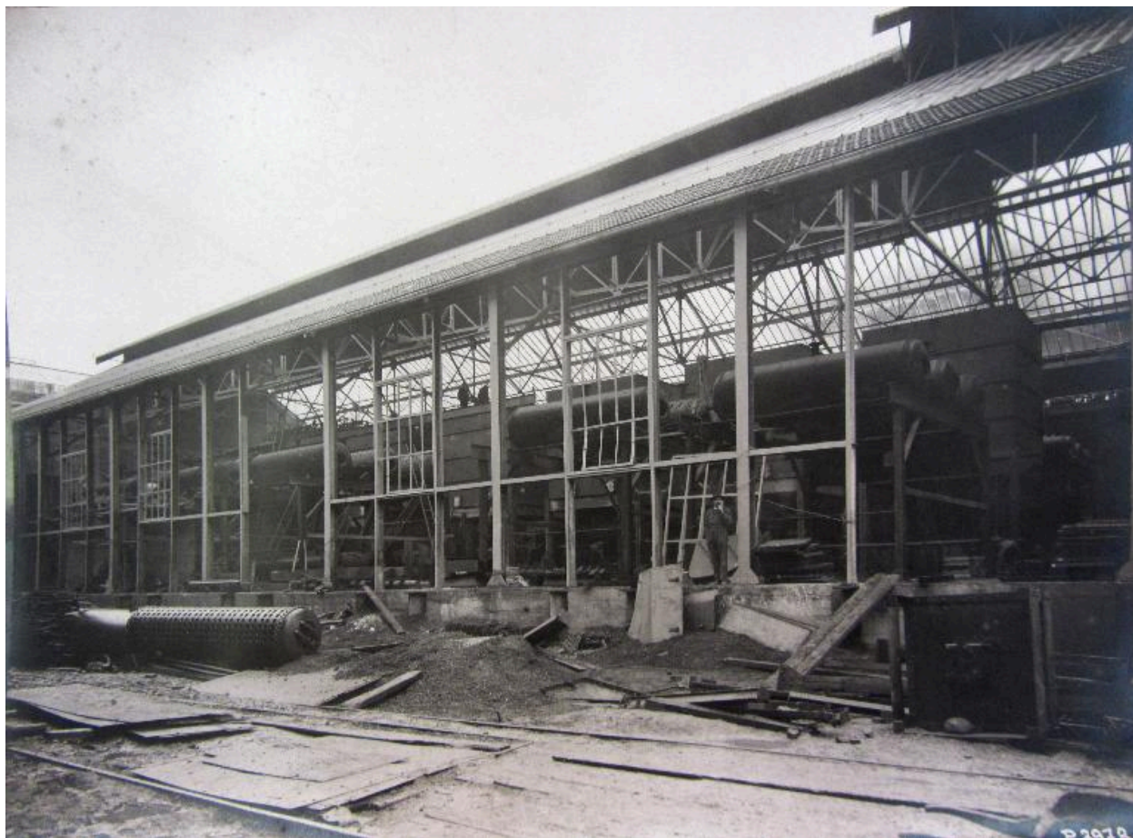
Vue extérieure d'un bâtiment en cours de construction, 6 novembre 1922 (AD Somme ; 49 Fi 17).
