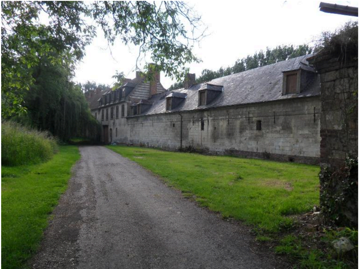
Vue de situation depuis le pont.
