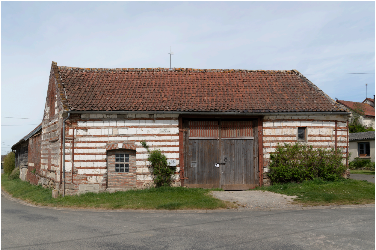
Ancienne grange sur rue avec un appareil en "rouges barres", n°35 de la rue de l'École, vue depuis l'est.
