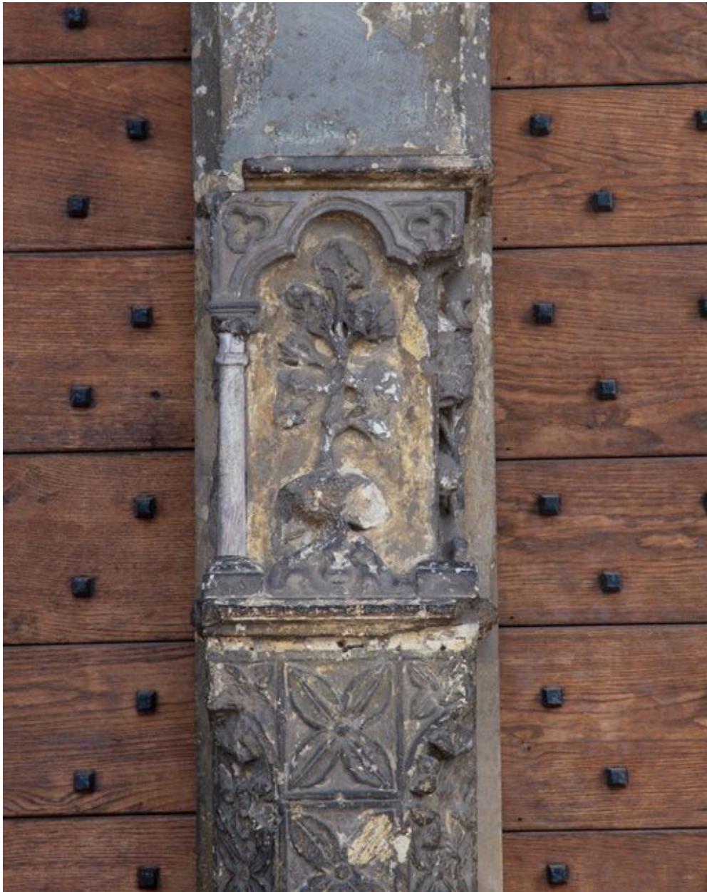
Portail central occidental, détail du trumeau.
