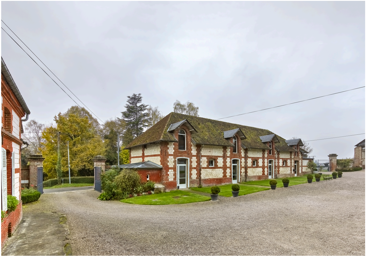
Vue de l'ancienne bergerie, depuis l'est.
