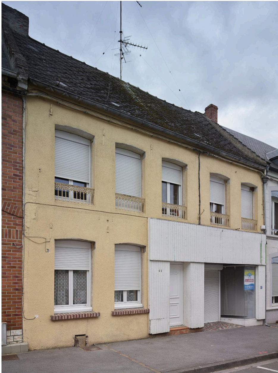
Maison, première moitié du XVIIIe siècle : pignons débordants, façade ordonnancée à 5 travées reprise au 1er niveau dans les années 1950, garde-corps panneau en fonte à motifs de lancettes et fleurons - 41, rue Thiers.
